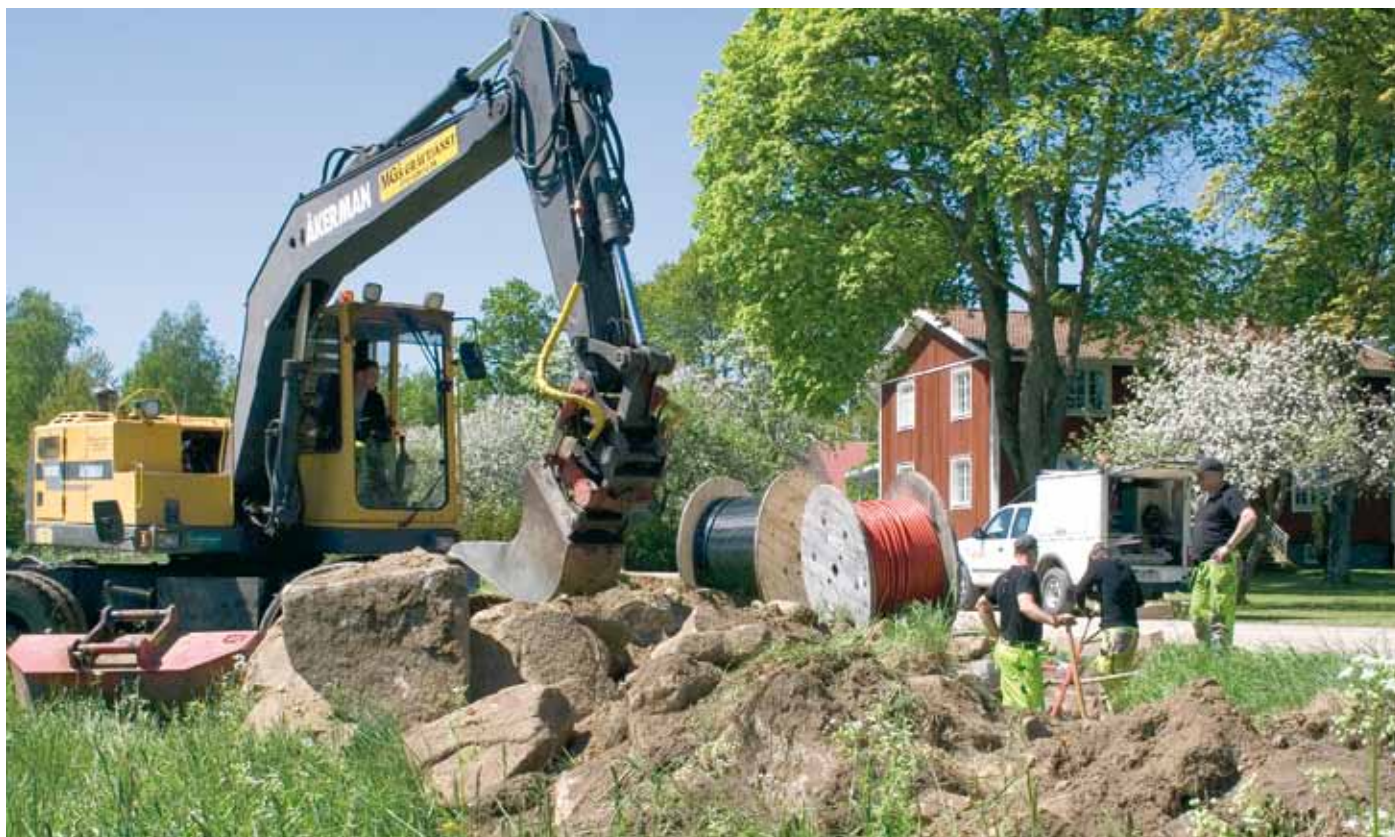
Grävning för nedläggning av stamfiber kommer under sommaren att pågå på flera håll inom Tingsryds kommun. Bilden är inte tagit i Tingsryds kommun.
